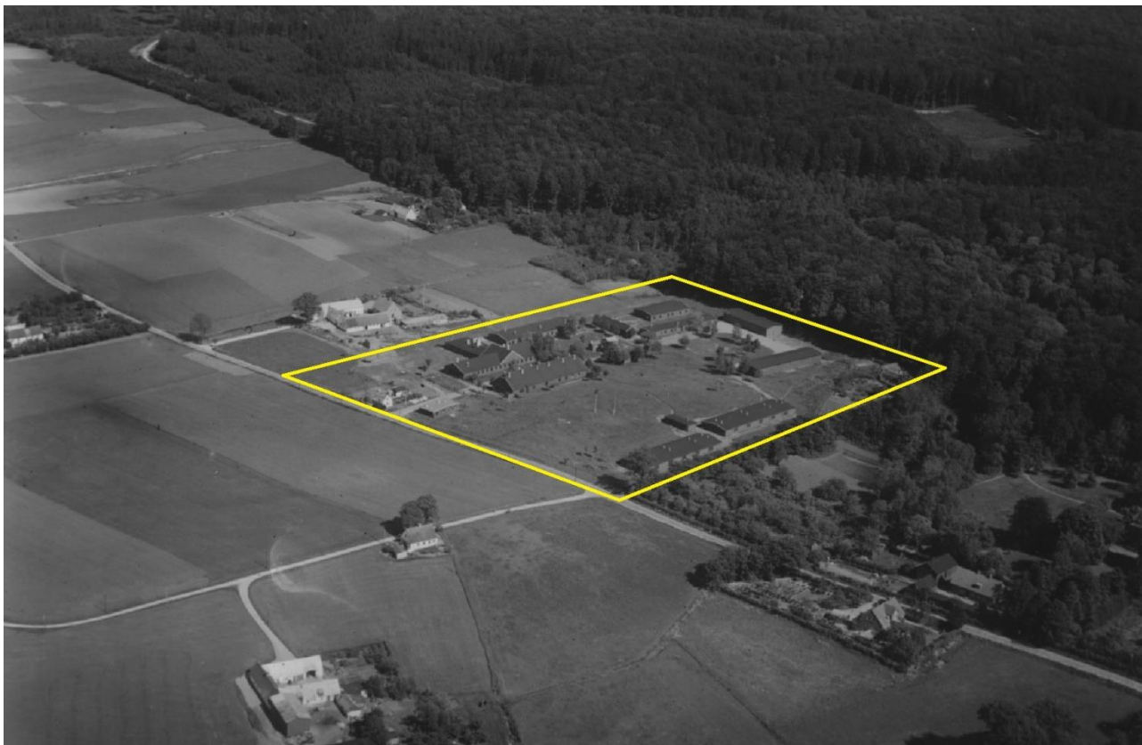
LUFTFOTO AF JONSTRUPLEJREN SOM DEN SÅ UD UNDER ANDEN VERDENSKRIG:
